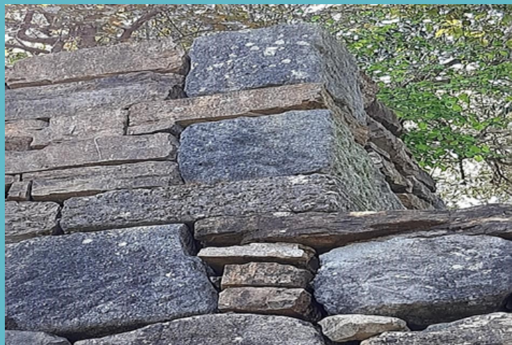
Marches d'un mur en pierre sèche, Seborga Imperia. Photo de R. Stancati (2021)
