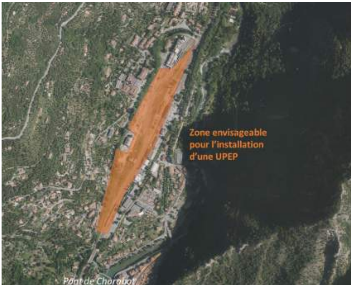
Figure 28 Photo aérienne de l'amont de la retenue de Breil-sur-Roya avec la zone susceptible d'accueillir l'UPEP, à proximité de la gare
