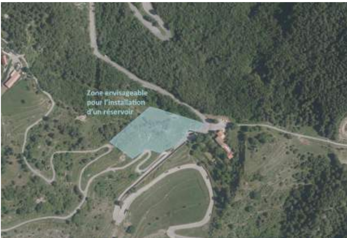
Figure 34 Vue aérienne du Col de Brouis et de la zone envisagée pour l'installation d'un réservoir
