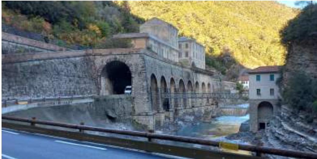
Figure 37 Photo de l'ouvrage route soutenant la gare de Piène Basse
