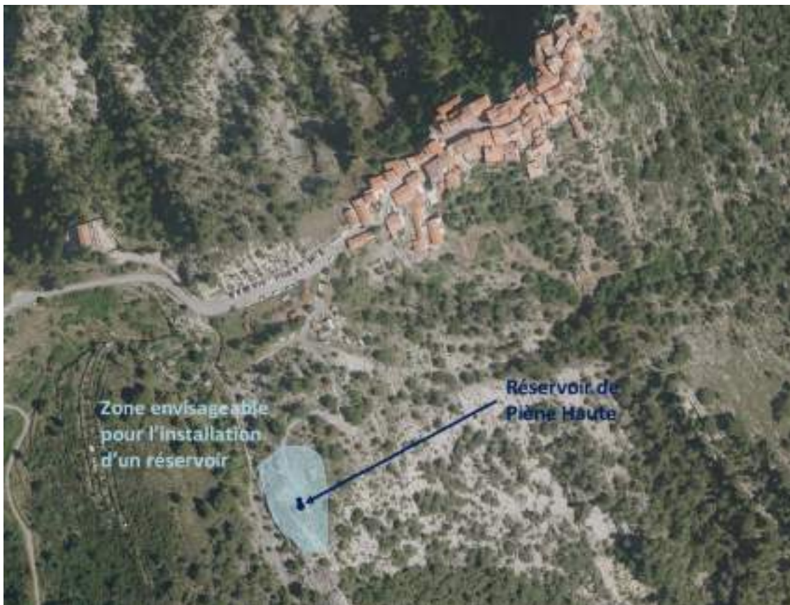
Figure 40 Vue aérienne de la zone envisagée à Piène Haute pour l'installation du réservoir de stockage pour le transfert de Piène Basse vers Sospel
