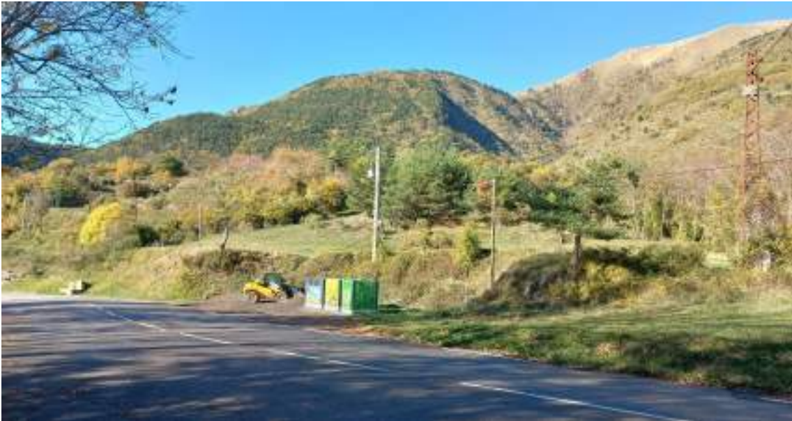
Figure 33 Photo du coteau sud est au-dessus du col de Brouis envisagé pour l'implantation d'un réservoir de stockage
