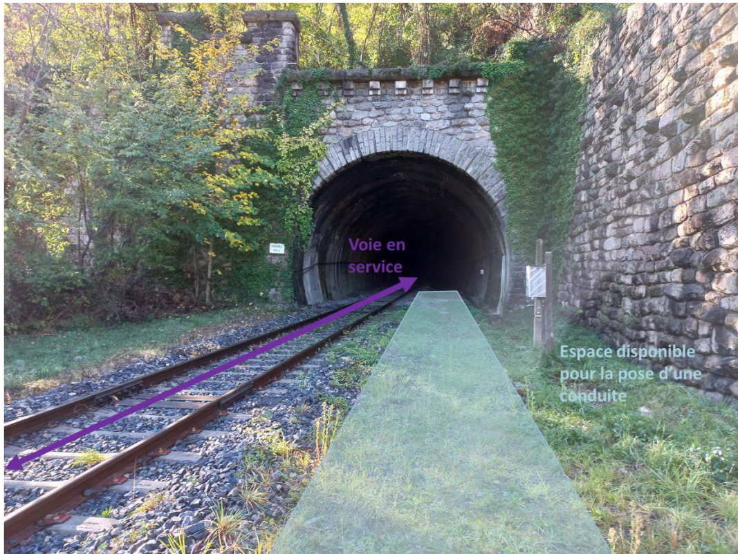
Figure 29 Photo de l'arrivée du tunnel en amont de la gare de Breil-sur-Roya
