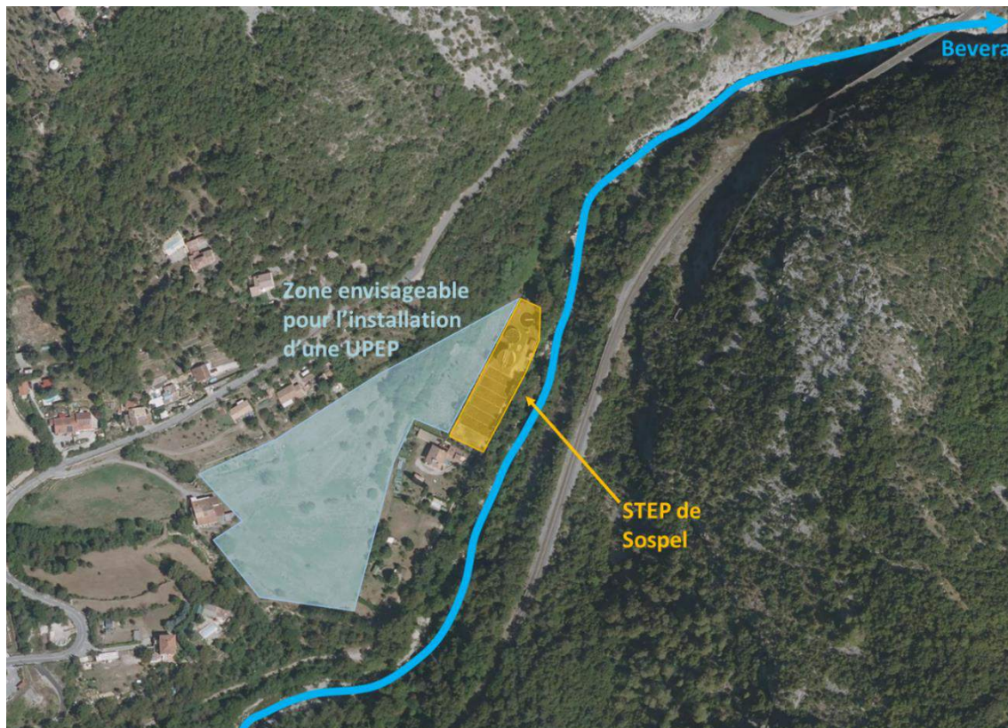
Figure 43 Vue aérienne du site envisagé pour l'installation d'une UPEP à proximité de Sospel
