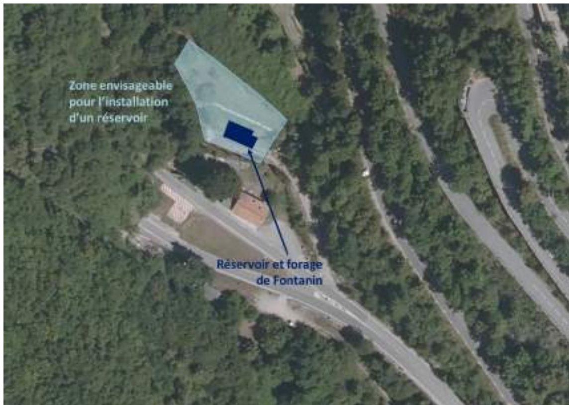
Figure 46 Vue aérienne du site envisagé pour l'installation d'un réservoir au Col de Castillon
