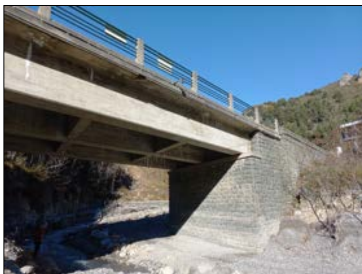
La Roya à Tende pont de Scara
