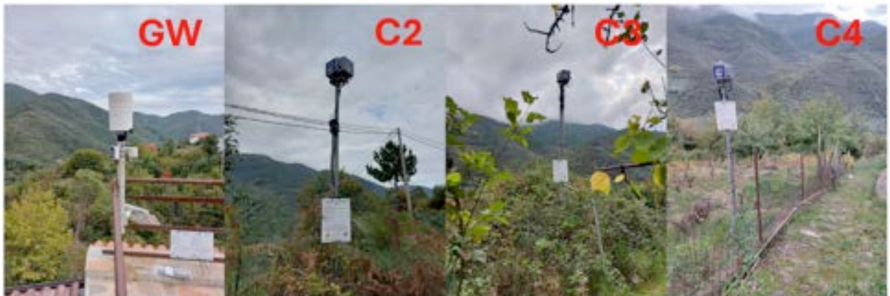
Le nuove installazioni a Ceriana Les nouvelles installations à Ceriana
