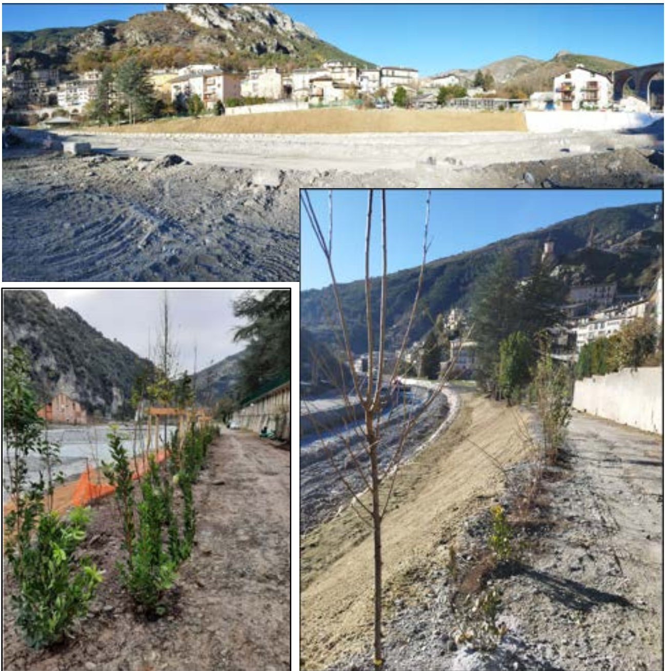
Lavori a Tenda ed a Breil Travaux de Tende et de Breil
