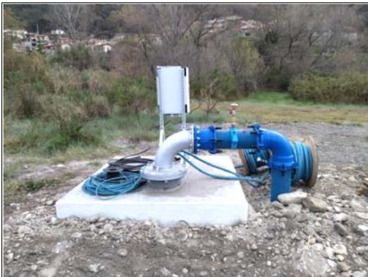
Protezione dell'imbocco del Sondaggio SP2 e raccordo delle tubazioni di pompaggio Protection de l'entrée d'enquête SP2 et raccordement des conduites de pompage
